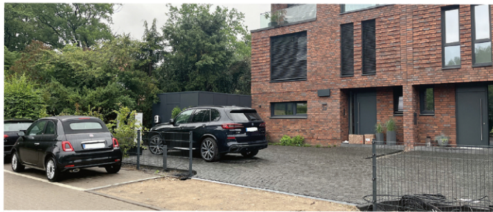
Zuvor war der gesamte Vorderbereich versiegelt, jetzt erfolgen Rückbaumaßnahmen.
